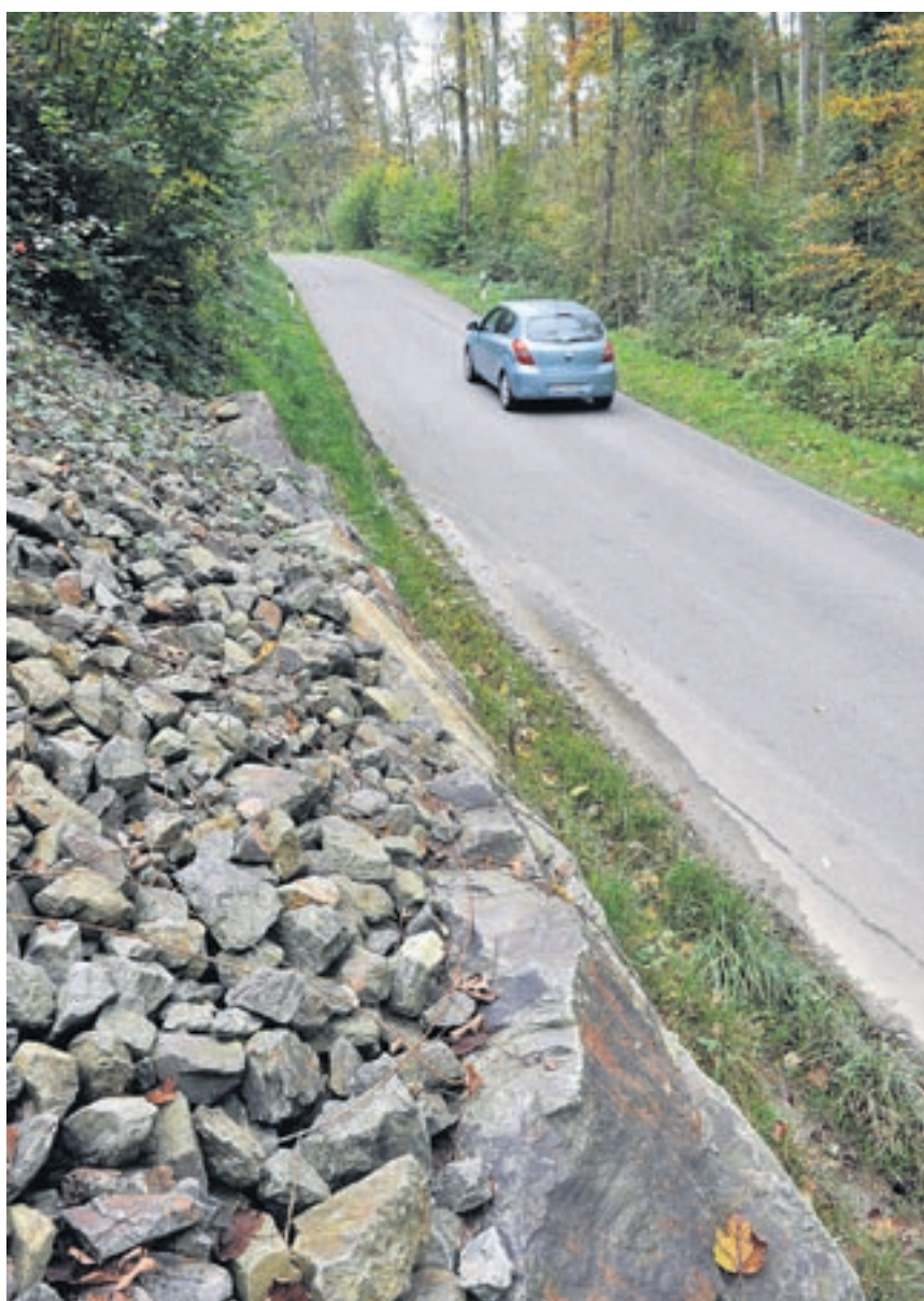
Nach der Sanierung soll kein Wasser mehr auf die Strasse laufen. Bild: Werner Schlaefli
